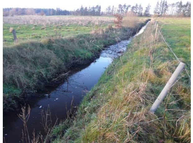
Bild 20: Ansicht der Linnau vor der Maßnahme
