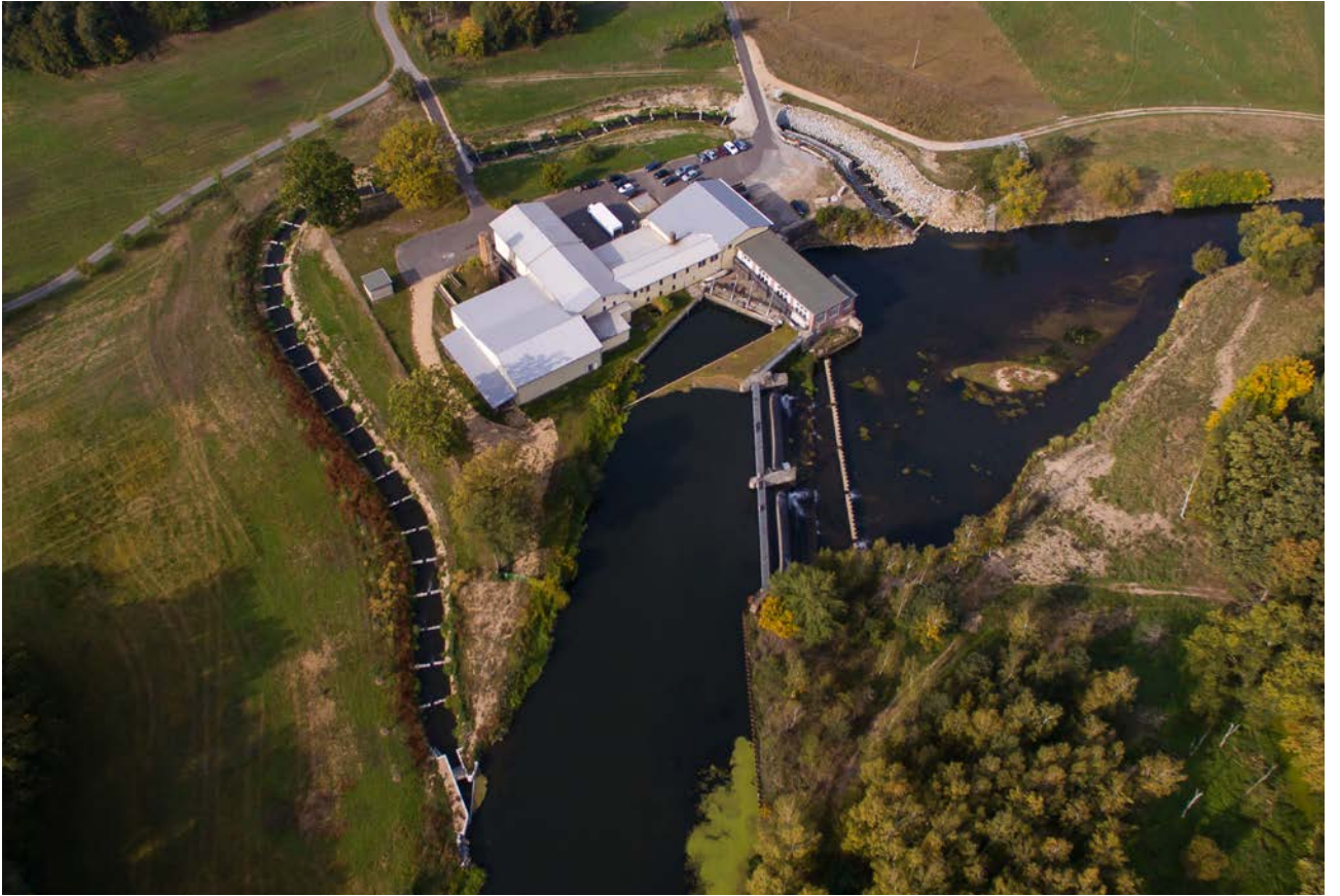
Bild 26: Luftaufnahme der Fischaufstiegsanlage
