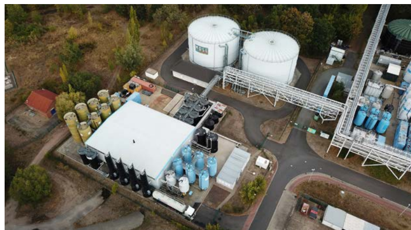
Bild 44: Luftbild der Grundwasserbehandlungsanlage im ÖGP Bitterfeld-Wolfen
