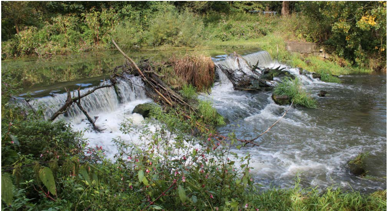
Bild 31: Das Wehr Mahlmühle vor Beginn der baulichen Umsetzung
