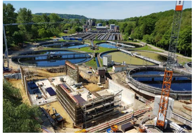
Bild 38: Sicht auf die im Bau befindliche Ozonungsanlage
