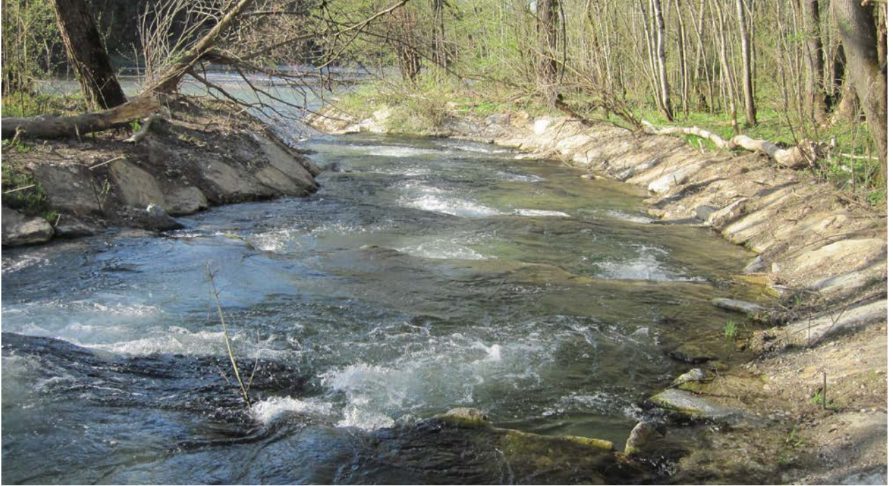
Bild 4: Raugerinnebeckenpass an der Mündung des Aumühlbachs, Bayern
