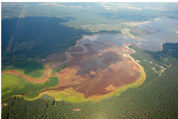
Bild 46: Die Talsperre Spremberg 2014 vor Beginn der Konditionierungsmaßnahme
