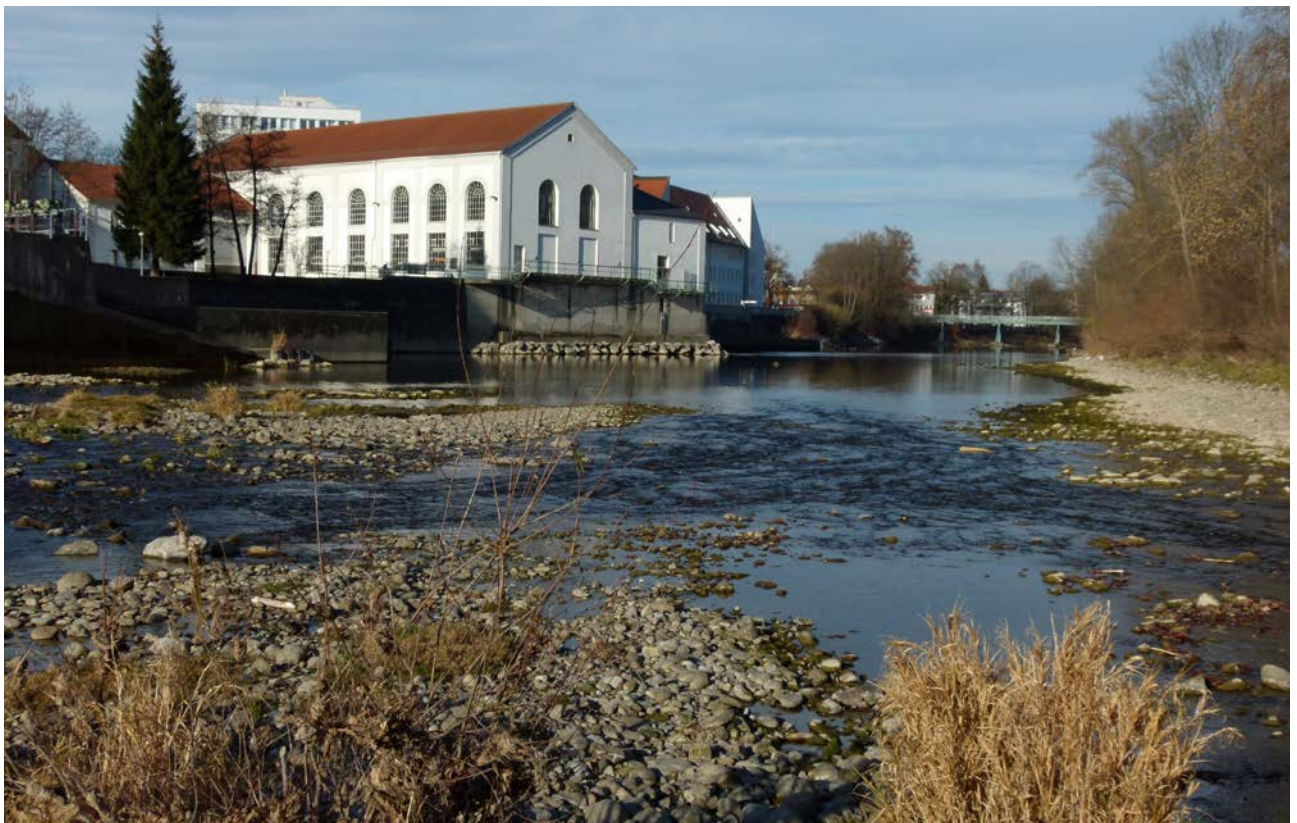
Bild 6: Blick in eine Ausleitungsstrecke der Iller, Bayern
