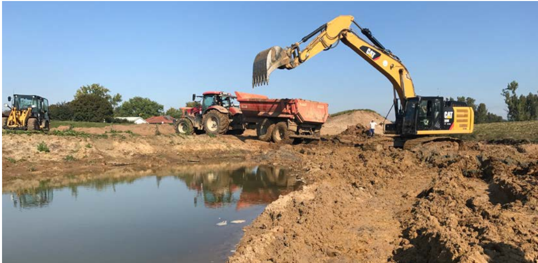
Bild 18: Baggerarbeiten während der Baumaßnahme „Weschnitzinsel“
