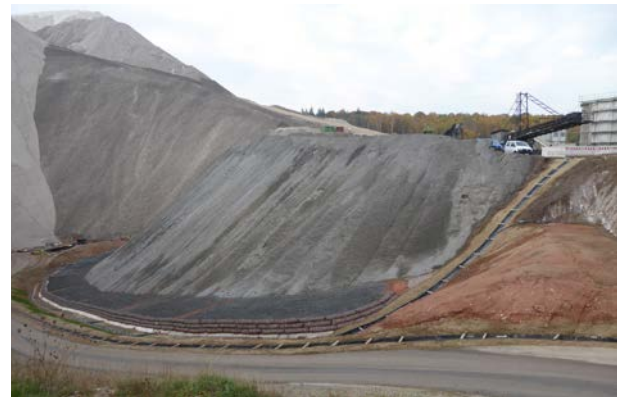
Bild 49: Abdeckung einer Haldenböschung mit Schlacken aus Hausmüllverbrennungsanlagen (HMVA) im Versuchsstadium
