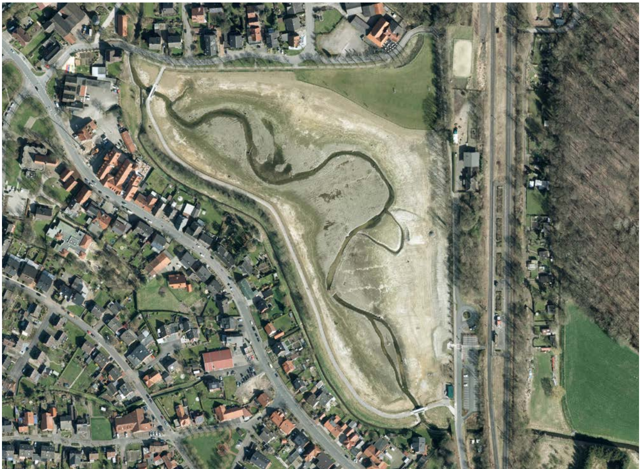
Bild 15: Emmerbach nach der Bauphase im Frühjahr 2017 (am Rand der Siedlung verläuft das alte Gewässerbett)
